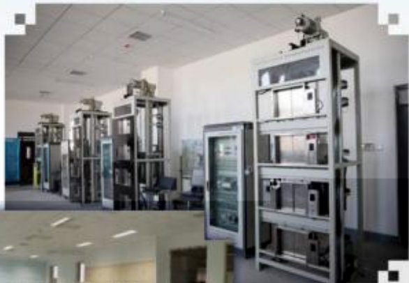
智能电梯安装调试 维护训练场所
